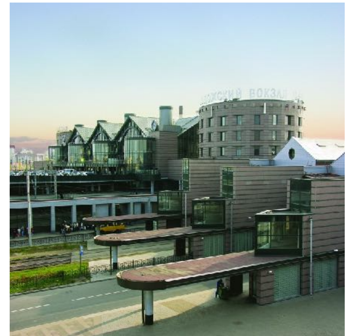
Вокзальный комплекс Ладожский, Санкт-Петербург Студия 44 Санкт-Петербург, Россия 2001 – 2002 / 2001 – 2003
