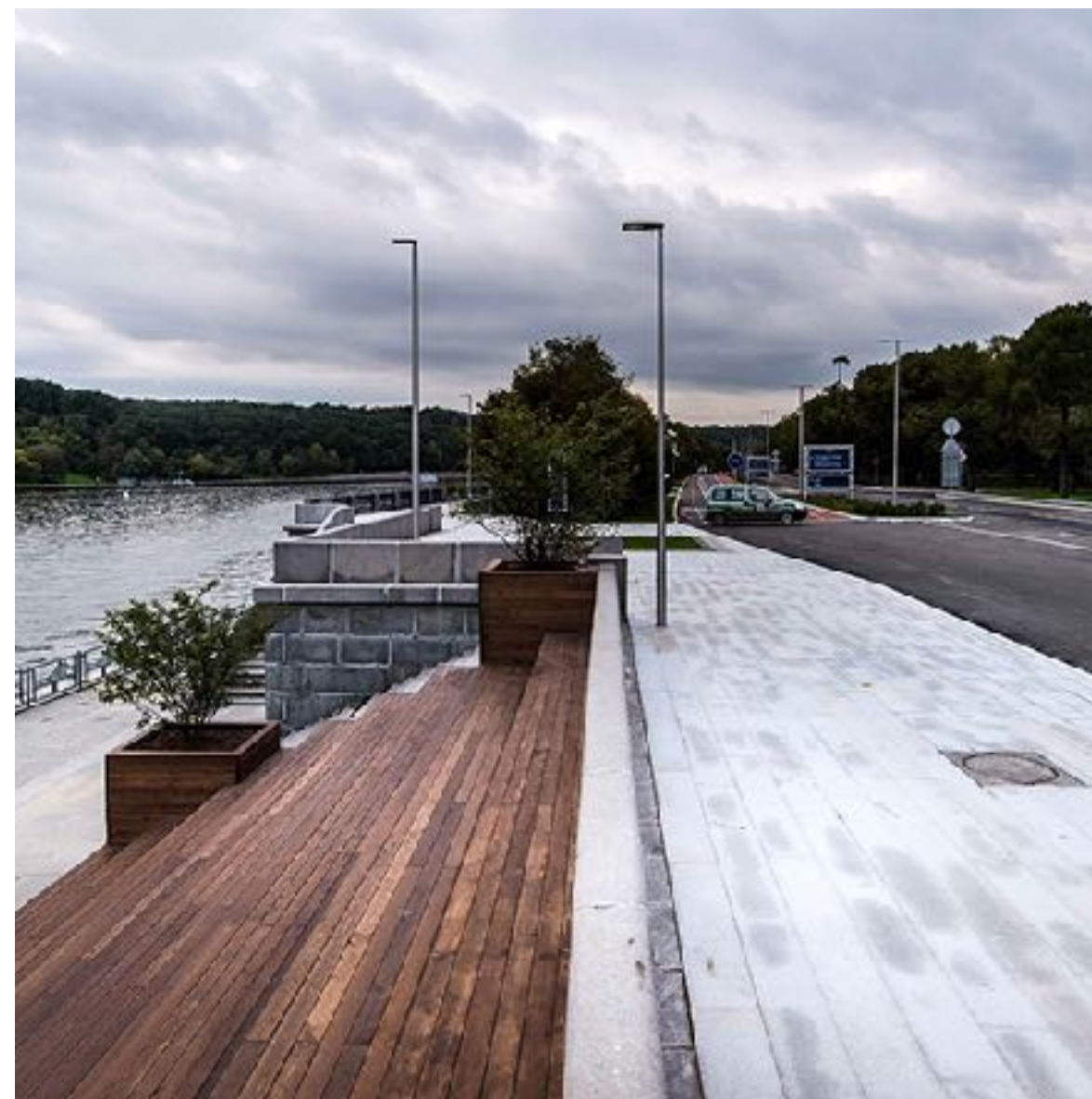
Реконструкция Лужнецкой набережной
