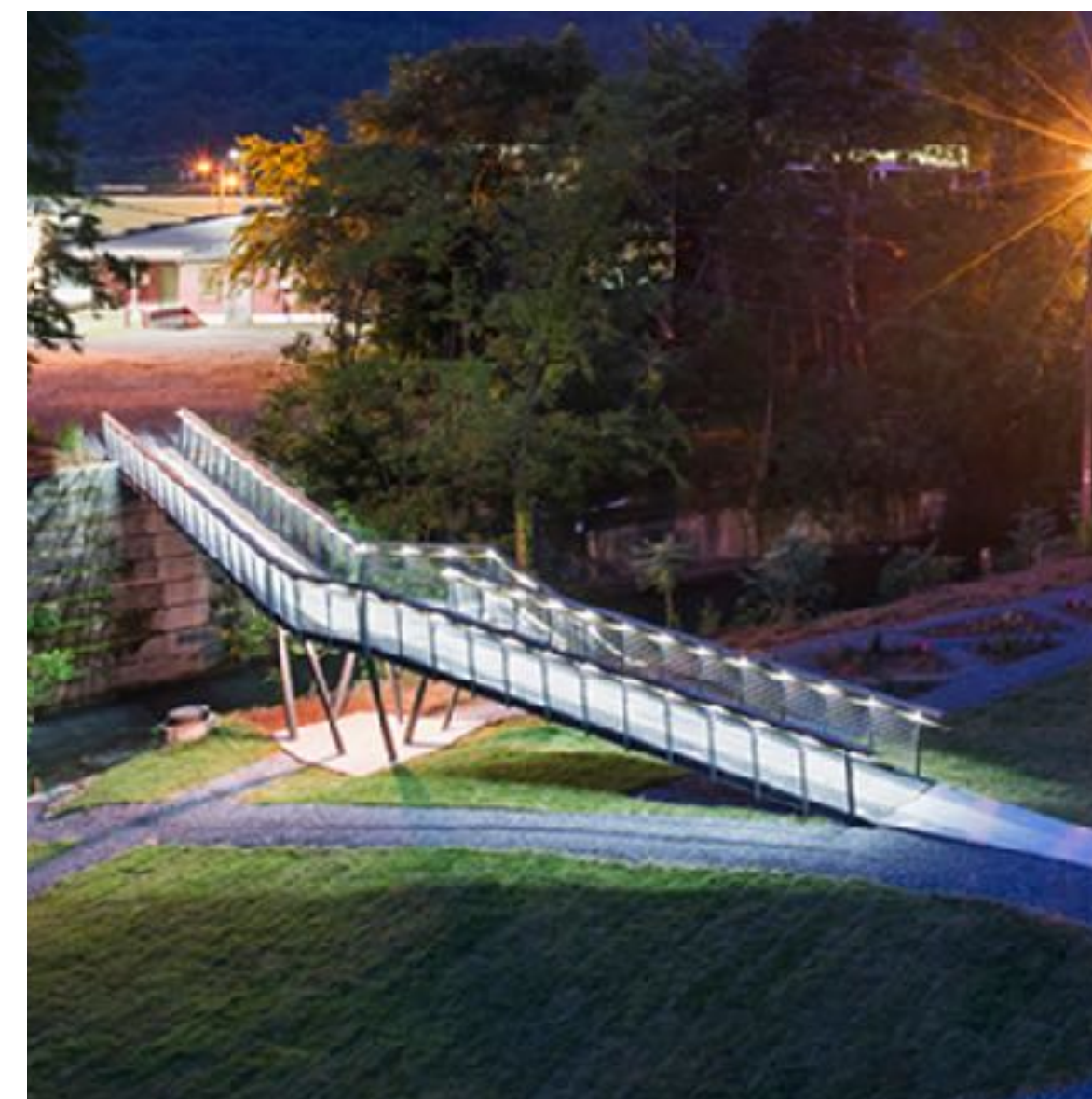
Пешеходный мост Smith Creek Авторы: buildLAB США 2013
