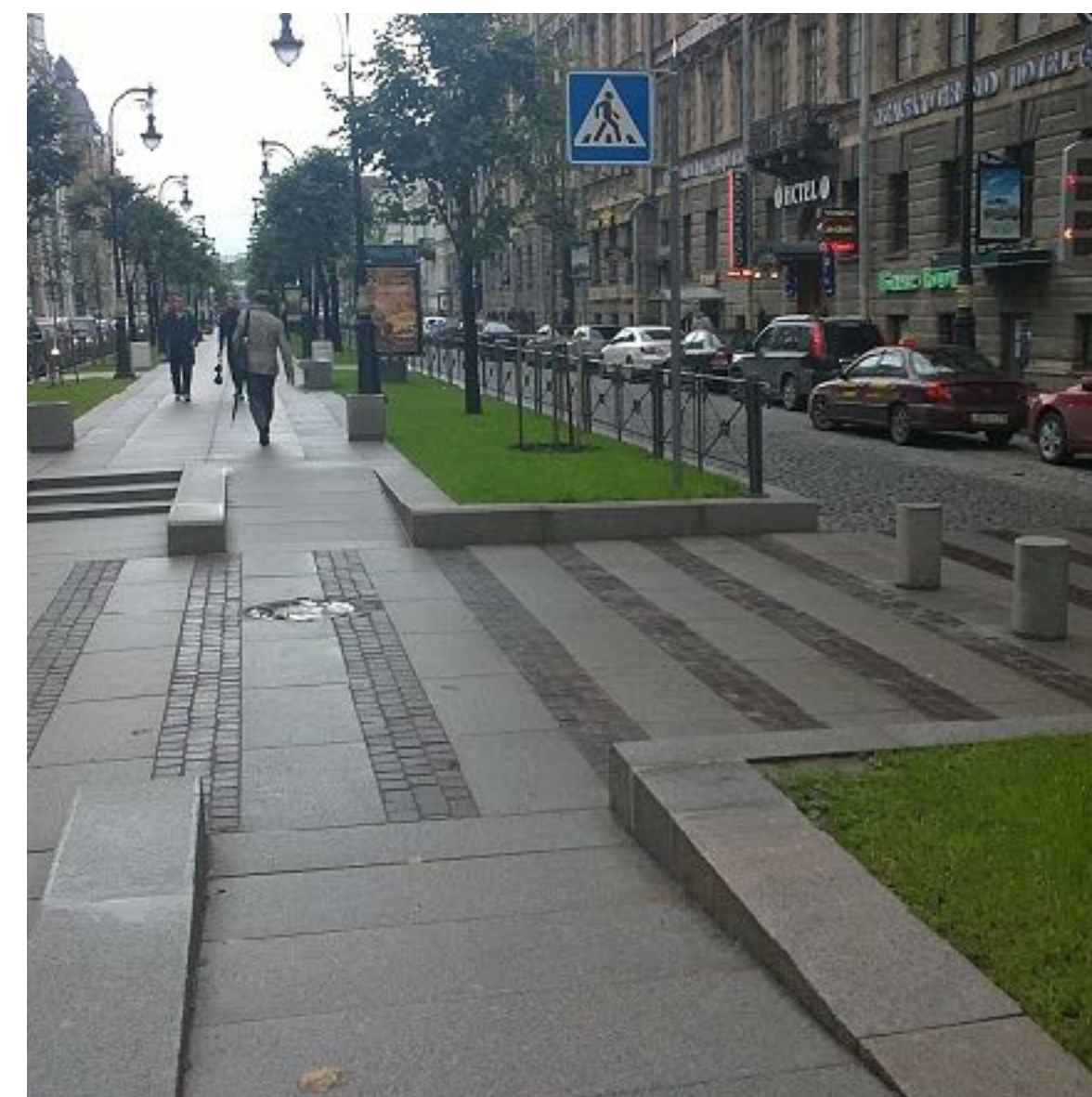
Реконструкция Большой Конюшенной улицы Санкт-Петербург, Россия 2010-2011
