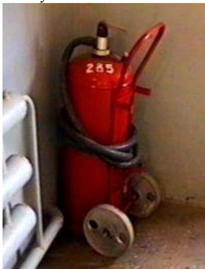
**Порошковые огнетушители (ОП)** предназначены для тушения пожаров твердых, жидким и газообразных веществ (в зависимости от марки используемого огнетушащего порошка), а также электроустановок, находящихся под напряжением до 1 кВ (1000 В). Принцип работы передвижного огнетушителя ОП-50(З) основан на вытеснении огнетушащего порошка (при открытом клапане запорного устройства) сжатым воздухом, находящимся в емкости. Для приведения огнетушителя в действие необходимо выполнить следующее:
